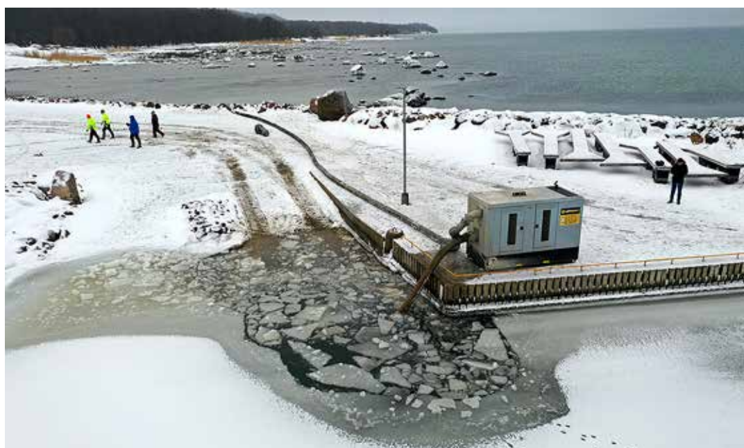
Et sadama akvatooriumi süvendada, pumbatakse see esmalt veest tühjaks. / Droonifoto: Ergo Eesmaa
