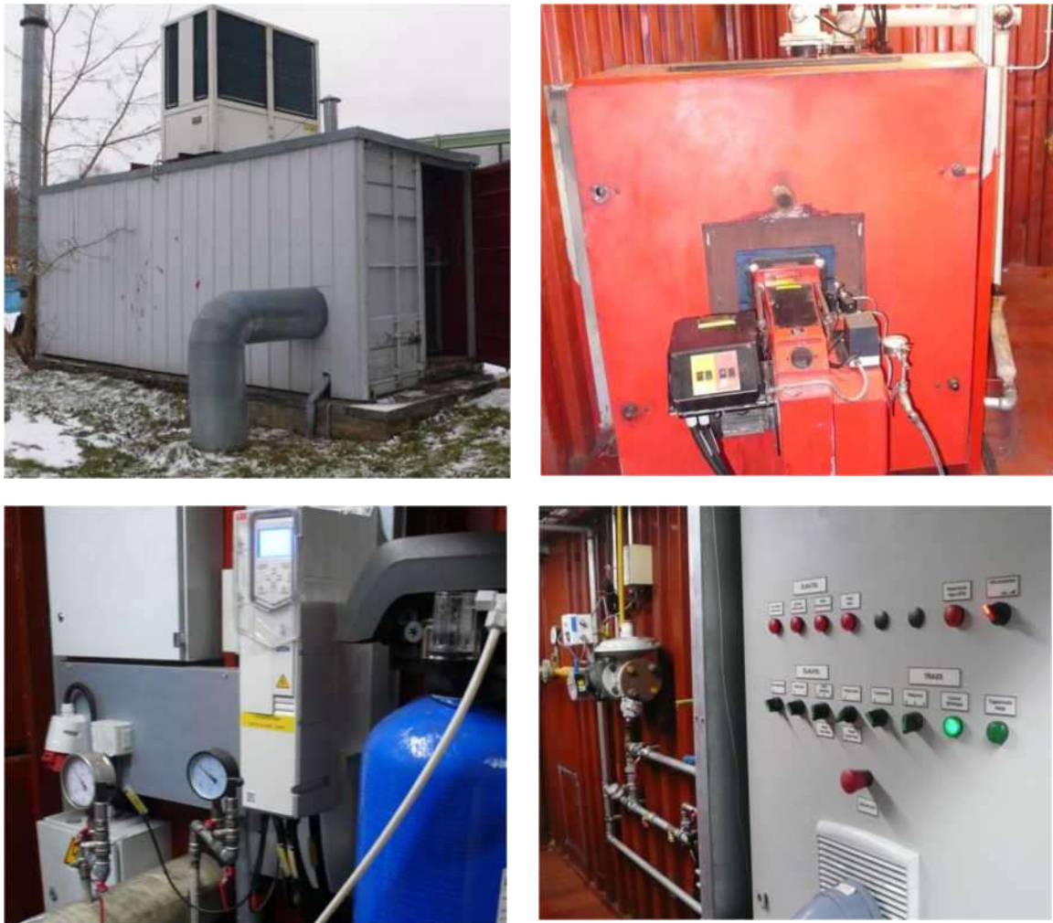
Joonis 2.2 Harku küla kaugküttesüsteemi konteinerkatlamaja. Foto V. Vares
