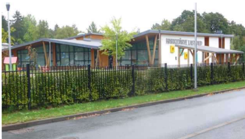
Joonis 5.8 Väineli tee 8, lasteaed, foto Google Maps
