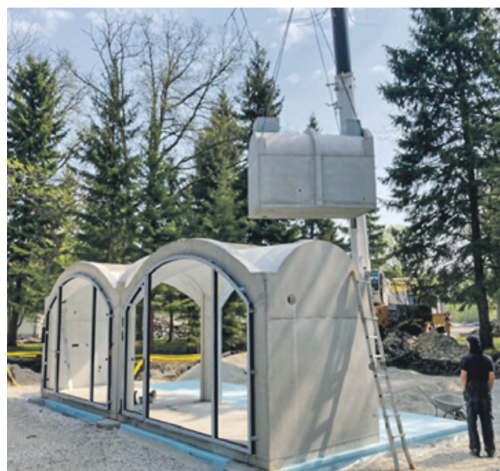
Nii valmib Revonia tootmishoones järjekordne keldri moodul, kokku tõstetakse need ühe päevaga. Fotod: Merike Pinn ja Revonia
