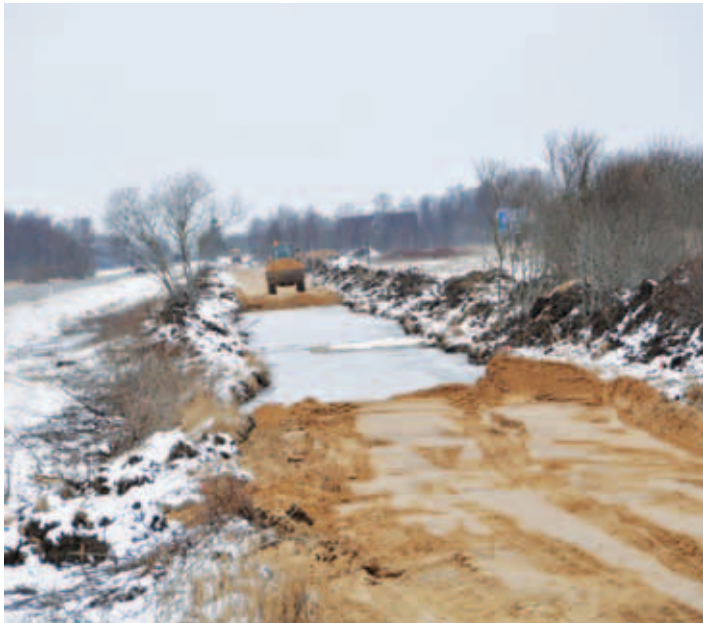
Pildil teostatakse tee muldkeha täitetöid.
