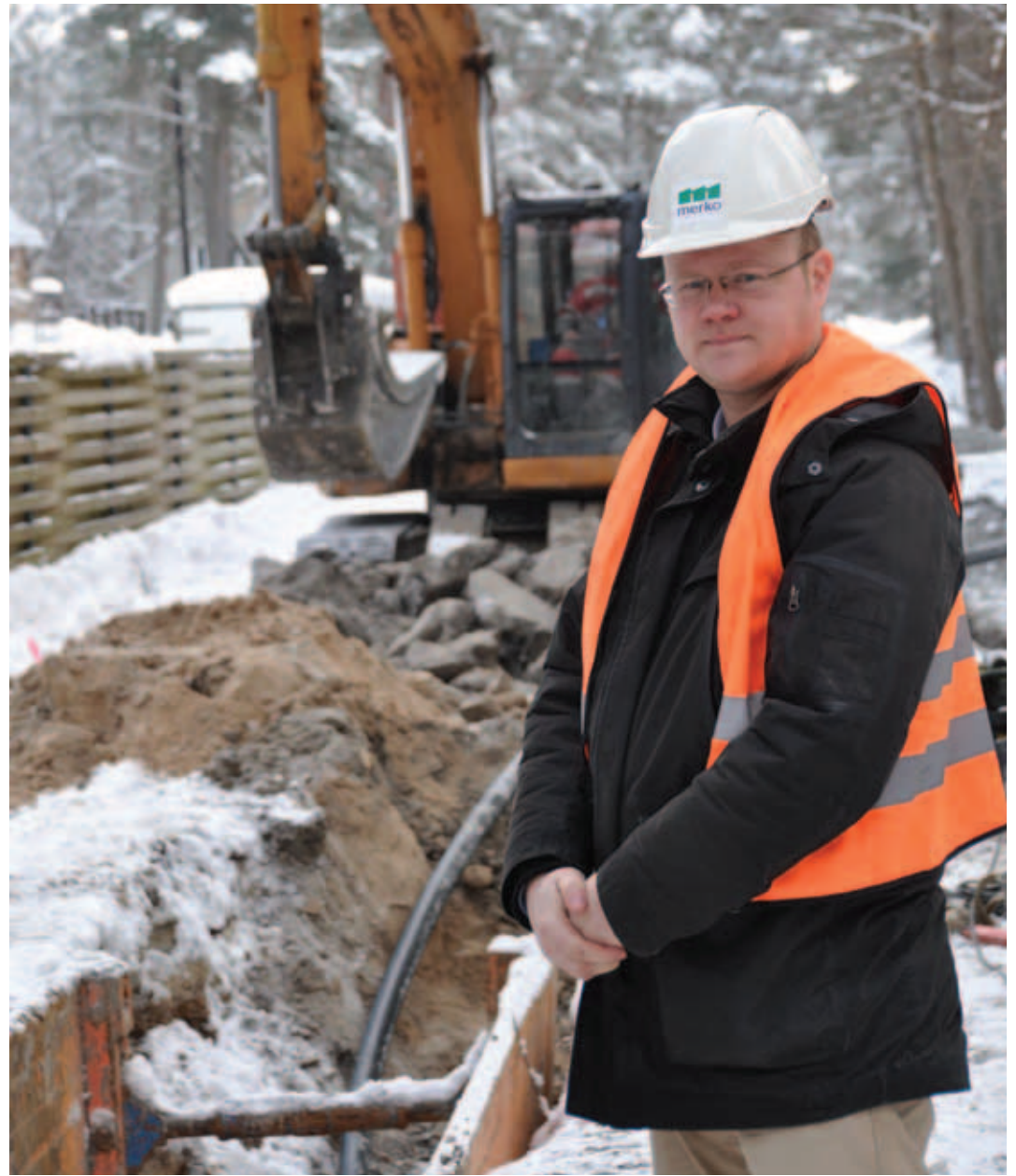
“Töö on keeruline veel seetõttu, et pinna on liivane, tuleb ehitada kaevendile toetus. Ka on suvilaühistute poolt maa sisse veetud märgistamata elektrijuhtmeid ja veetorusid,” näitab projektijuht Peeter Laidma üht ekskavaatori kopa ette jäänud toru. Ülo Russak
