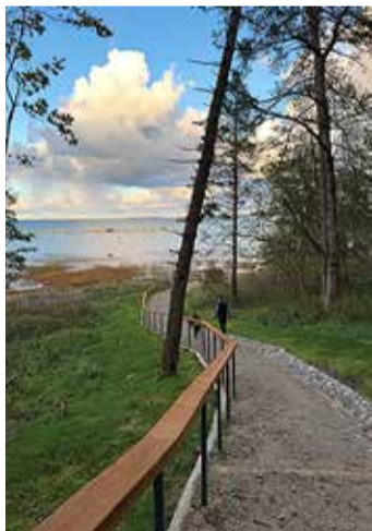
Uus Merepiiga trepp ja korrastatud jalgrada. / Foto: Janika Kleemann
